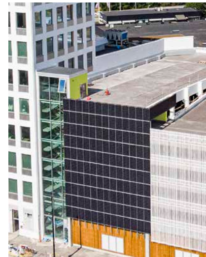
▲ Solpaneler på p-huset Drottningen.
